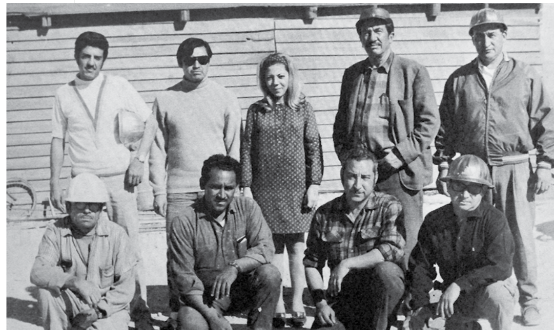
← Equipo de construcción Juárez. Juárez construction team.
